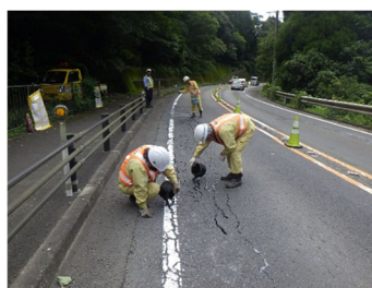
【ひび割れの補修】
