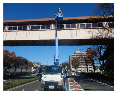
【横断歩道橋点検】
