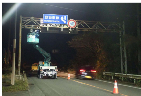
【附属物（門型標識）点検】
