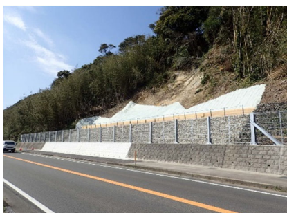
【法面对策（落石防止柵）】
