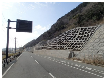
【法面对策（法枠工）】
