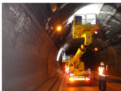
【トンネル点検】
