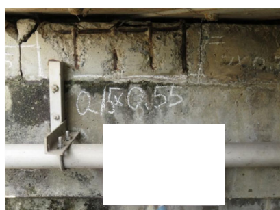
【コンクリート劣化・剥落】
