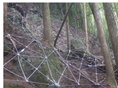
【法面对策（ロープネット工）】
