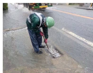
【大雨時の排水構造物確認】
