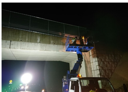
【大型カルバート点検】
