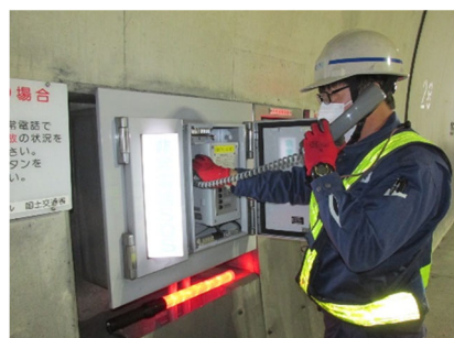
【トンネル非常用設備の点検】
