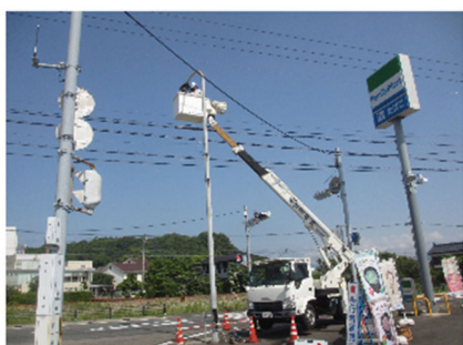
【道路照明ランプ交換】
