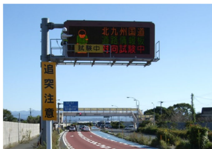
【道路情報板の点検】
