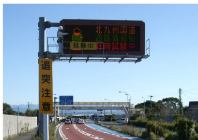
【道路情報板の点検】
