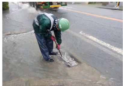
【大雨時の排水構造物確認】
