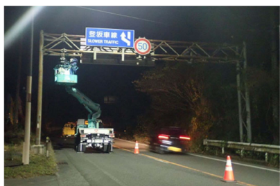
【附属物(門型標識)点検】
