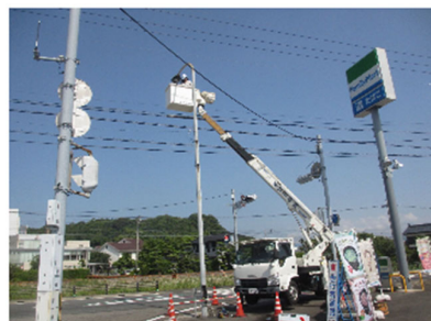
【道路照明ランプ交換】
