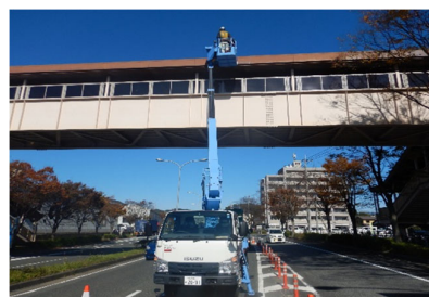
【横断歩道橋点検】
