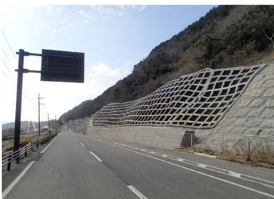
【法面对策（法枠工）】
