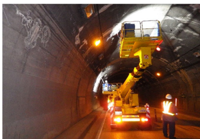
【トンネル点検】
