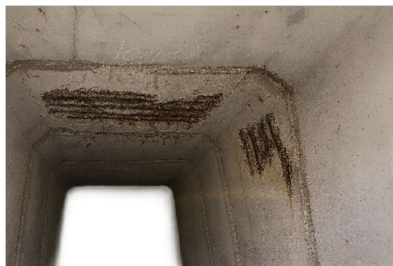
【コンクリート劣化・剥落】
