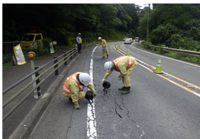
【ひび割れの補修】
