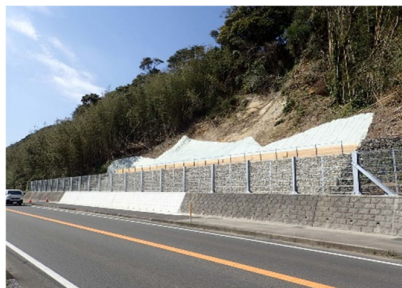
【法面对策（落石防止柵）】
