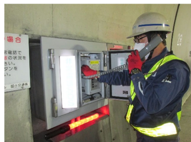
【トンネル非常用設備の点検】
