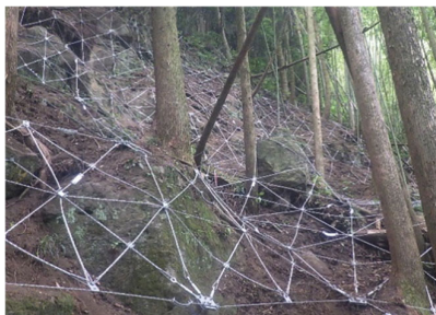
【法面对策（ロープネット工）】
