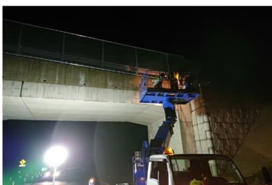
【大型カルバート点検】
