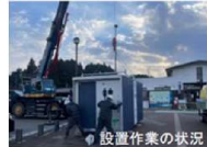
設置作業の状況
