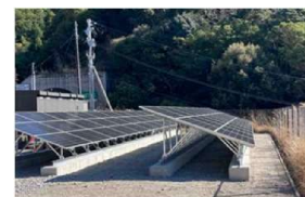
太陽光発電施設の設置
