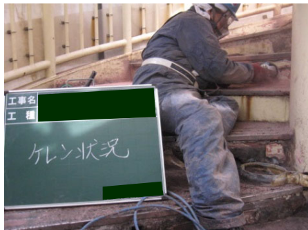
補修状況（鋼材防食塗装）
