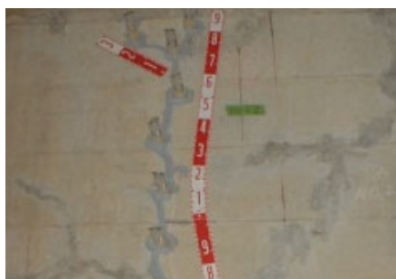
補修状況（ひび割れ補修）
