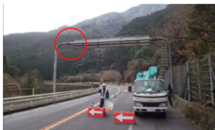
補修状況（ボルト取付）
