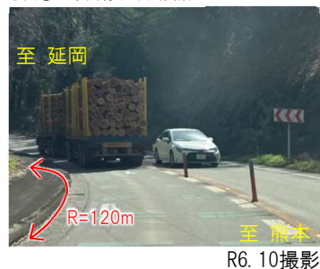
写真①：平面線形不良箇所
