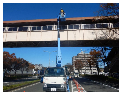
【横断歩道橋点検】
