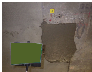
【壁面の断面修復】
