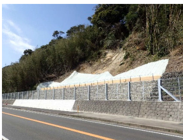
【法面对策（落石防止柵）】
