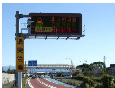
【道路情報板の点検】
