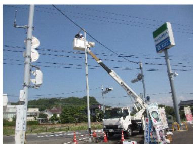
【道路照明ランプ交換】
