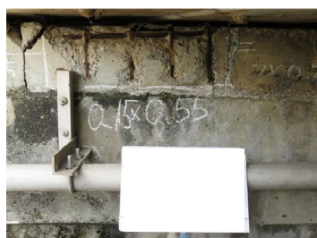
【コンクリート劣化・剥落】
