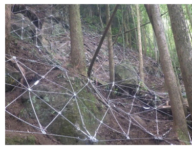
【法面对策（ロープネット工）】
