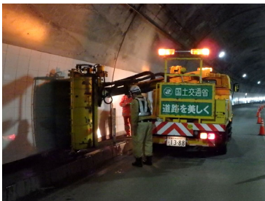
【トンネル清掃】
