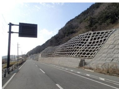
【法面对策（法枠工）】
