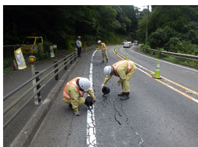
【ひび割れの補修】
