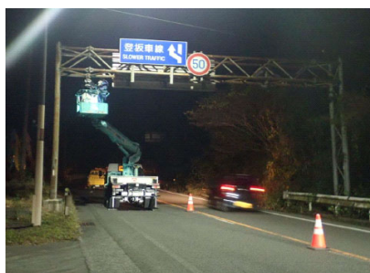
【附属物(門型標識)点検】
