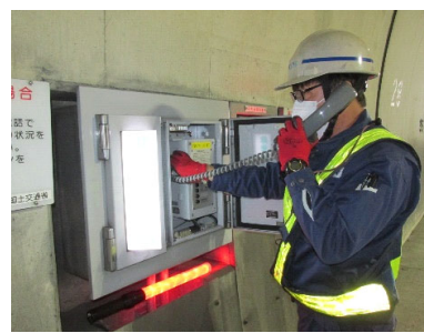
【トンネル非常用設備の点検】
