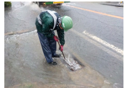
【大雨時の排水構造物確認】
