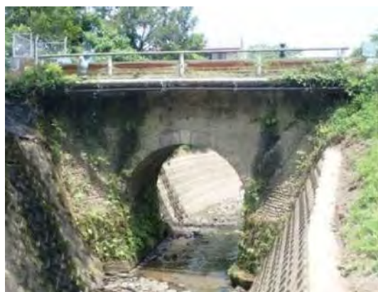
写真-2.8 石造アーチ橋の上部にコンクリート床版を設置している事例
