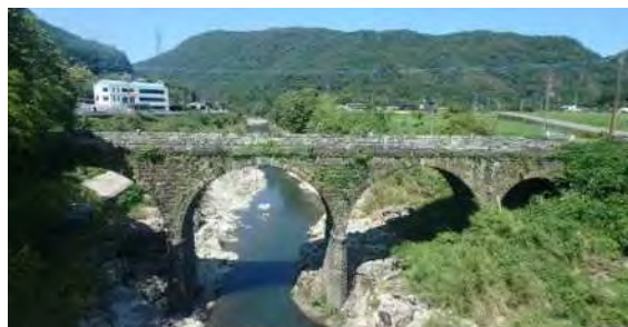
写真-2.2 橋脚を有する多径間の事例
