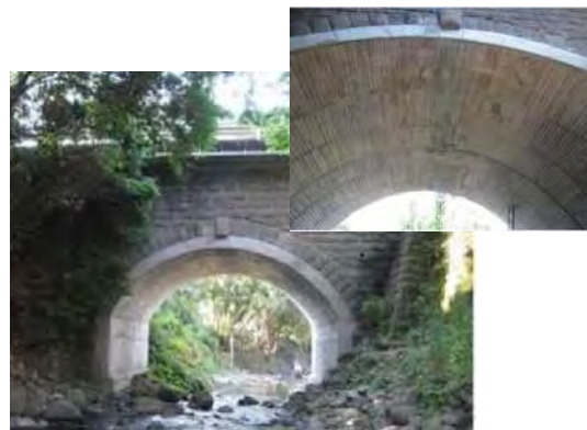
写真-2.7 輪石全体を補強している事例
