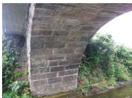
写真-2.4 目地（処理有り）
