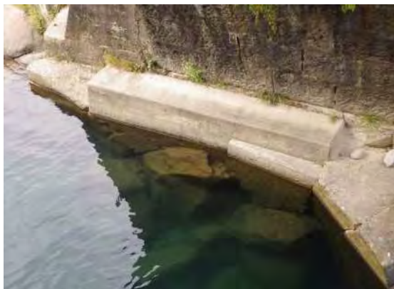
写真-2.6 基礎部分を補強している事例
