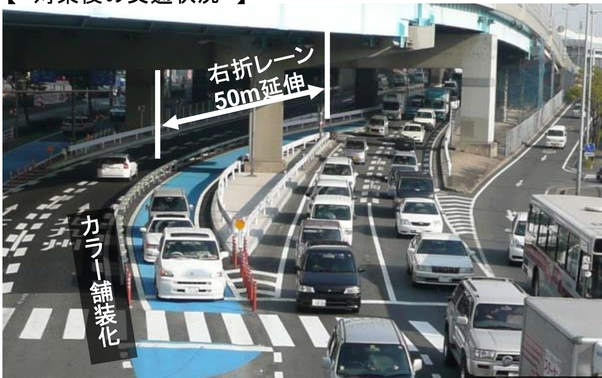
「右折レーン設置+カラー舗装化」を実施した箇所の削減効果
