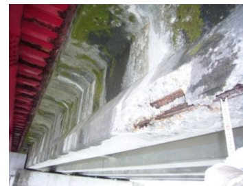
◆ 損傷状況 (主桁のコンクリート剥落)
