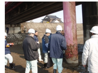
◆ 現地における橋梁点検状況
