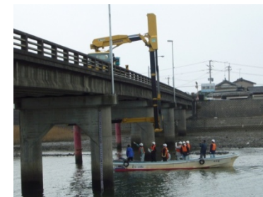
◆ 現地における橋梁点検状況
