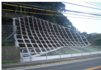
&lt;コンクリート法枠&gt;
