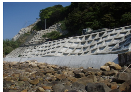
工事後&lt;ブロック積擁壁工&gt;
