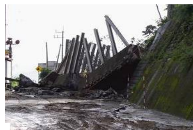
台風14号による牛根地区の被災被害状況(H17年)
