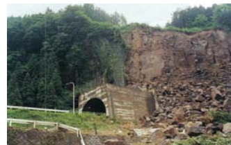
図3 災害発生状況 滝瀬トンネル付近 (57. 7. 16)
