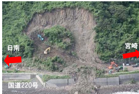
H20宮浦地区の状況
