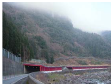
図4 参考：現道区間状況 赤岩地区 (現在)
