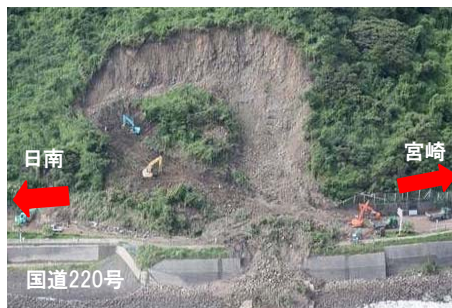
H20宮浦地区の状況
