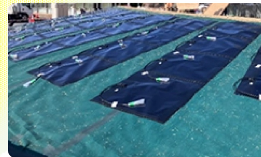
防草シート上の設置状況
