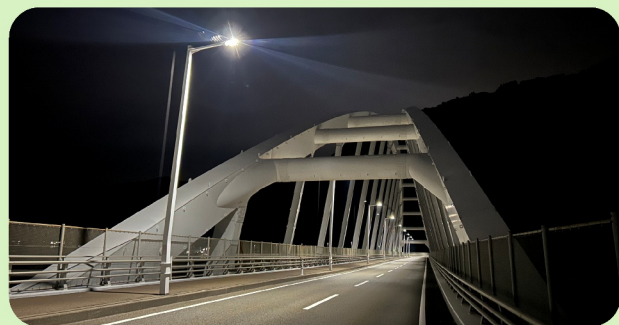
道路照明のLED化
