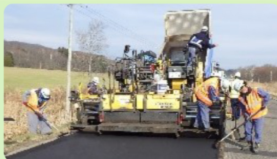
低炭素アスファルト舗装の施工状況
