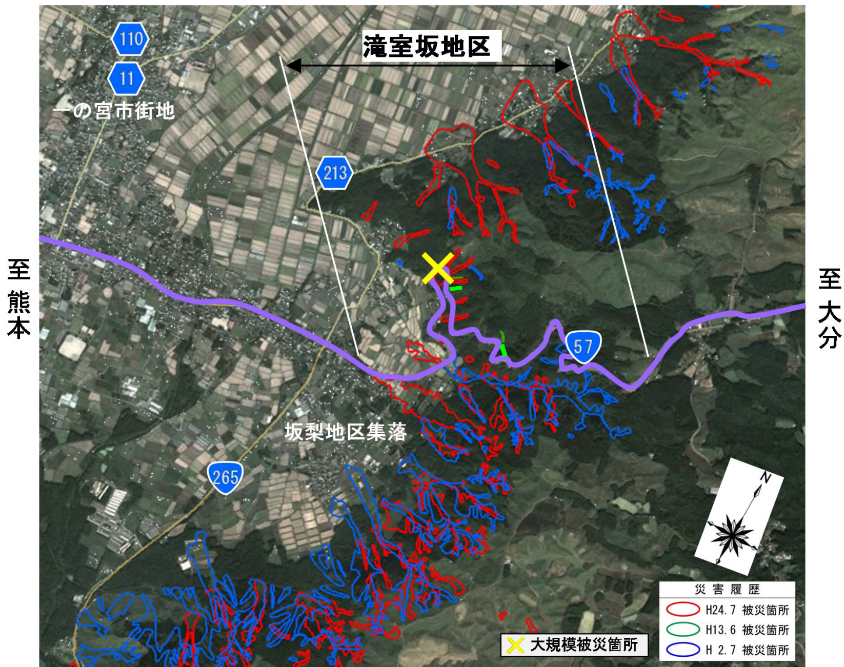
被災箇所(H2、H13、H24)
