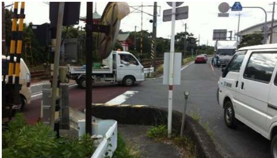
▲国道389号(新山踏切)の状況
