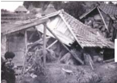
▲地震で倒壊した家屋(1961年)
