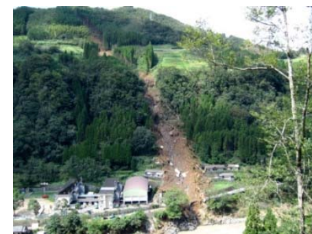
▲西臼杵郡日之影町 斜面崩壊(H17.9)
