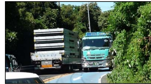
写真① 線形不良箇所(国道204号)
