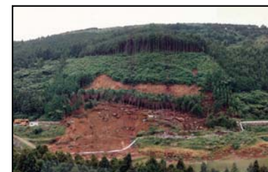
写真2 法面崩壊状況（江迎地区）H3.6.9
