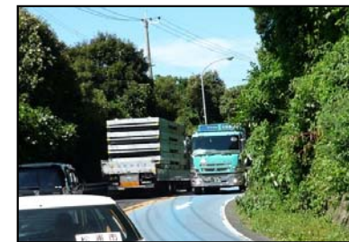
写真1 平面線形不良箇所（国道204号）
