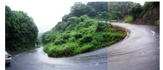
写真③ 線形不良箇所(県道松浦江迎線)
