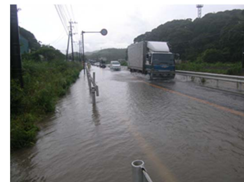
写真②：並行する国道3号 【大雨による冠水状況】
