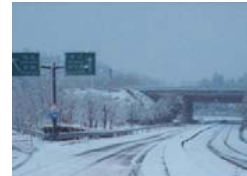
写真4 九州縦貫自動車道の積雪状況
