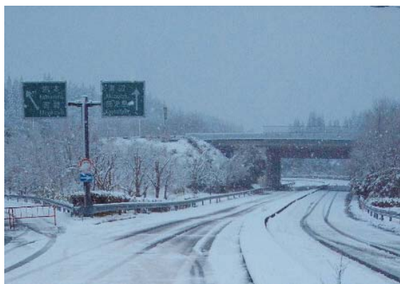
写真1 九州縦貫道路面積雪状況 (H26. 12. 17)
