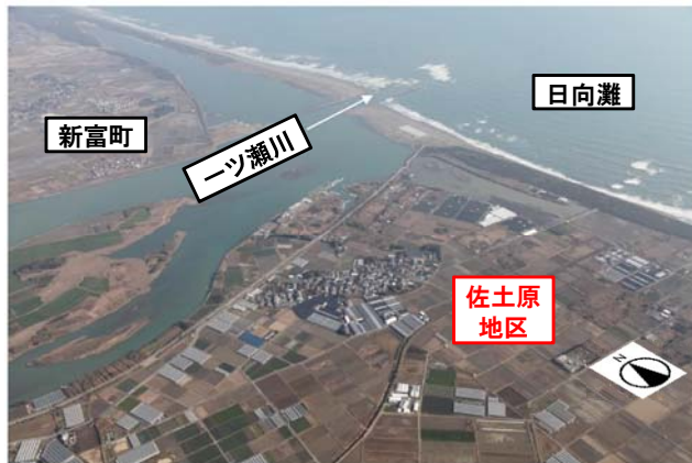
▲避難の困難が予測される地区の一つ浸水区域（一ツ瀬川河口周辺：佐土原地区）
