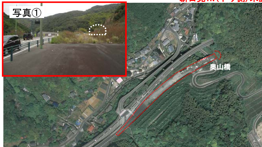
▲終点側トンネル坑口付近
