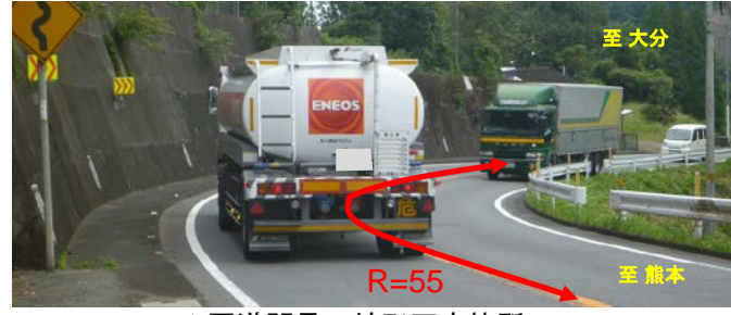
▲国道57号の線形不良箇所
