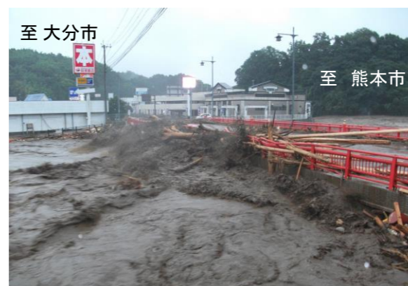
写真4 H24.7九州北部豪雨の被災状況
