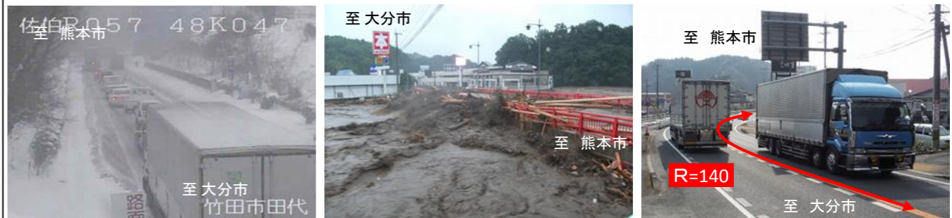
▲H26.2積雪時スタック発生状況(写真①) ▲H24.7九州北部豪雨被災状況(写真②) ▲平面線形が厳しい箇所(写真③)
