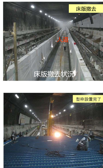
◆床版取替工事(海底部)の実施状況
