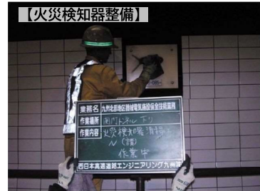
【火災検知器整備】
