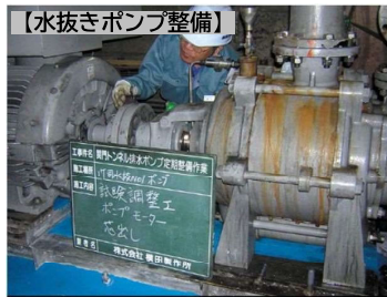
【水抜きポンプ整備】
