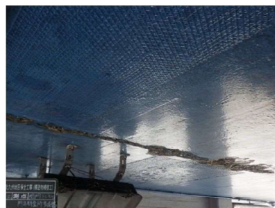
【料金所上屋構造物補修】
