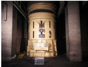
【換気設備更新】
