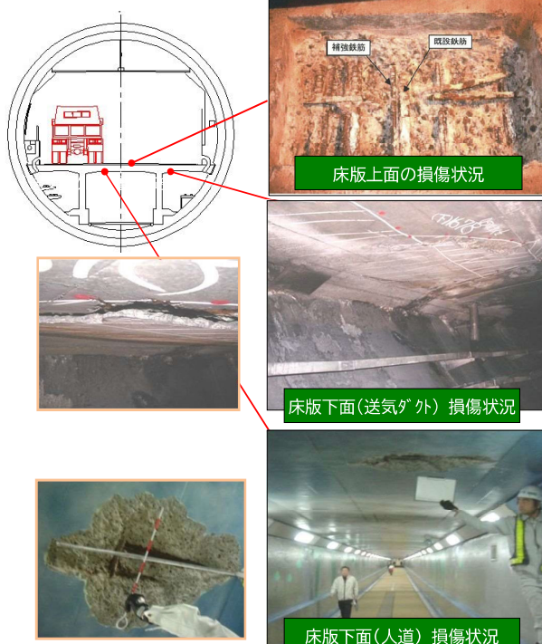
◆海底部床版取替前の状況
