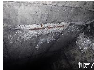
S 1 区間 床版下面の鉄筋露出
