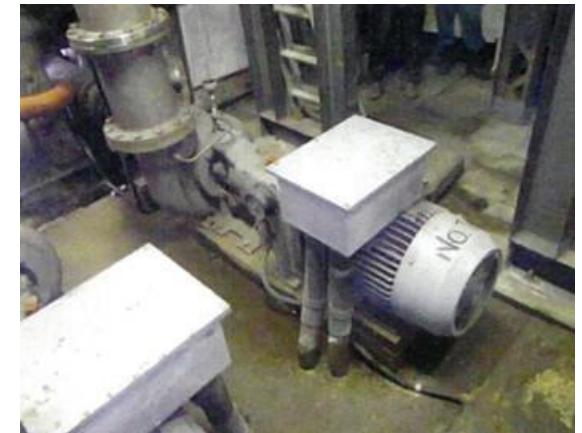
【排水ポンプ更新】
