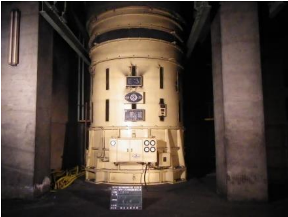
【換気設備更新】
