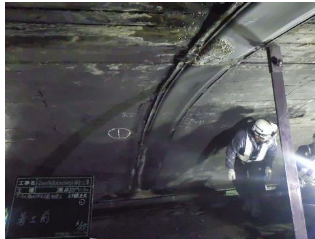
【漏水防止樋取替】
