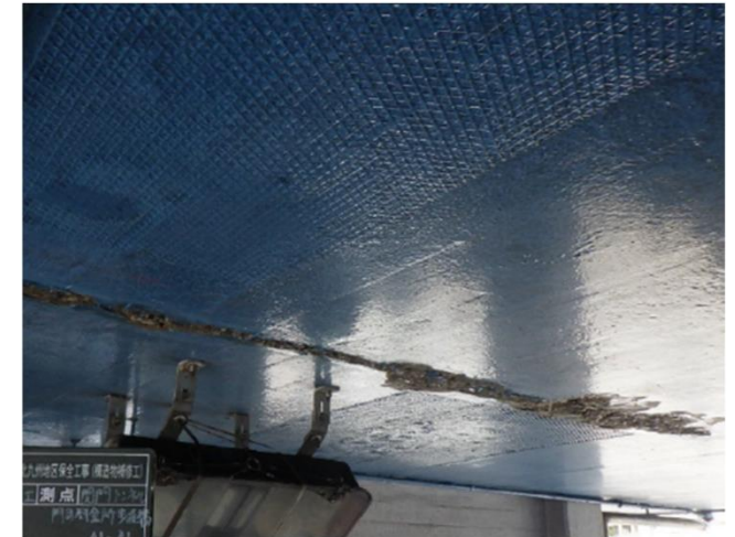
【料金所上屋構造物補修】
