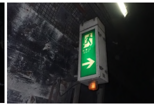
誘導標識 (設置から14年経過)
