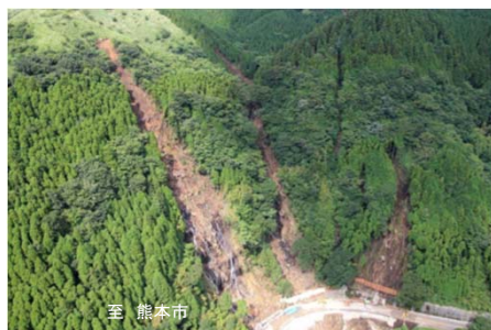
写真2 H24.7九州北部豪雨の通行止め(滝室坂)
