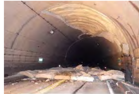
断層変位による損傷状況
