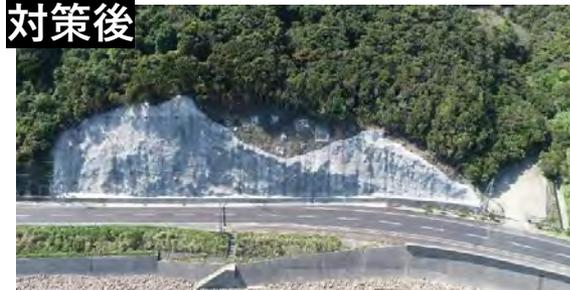
法面吹付工、落石防止網工による対策実施
