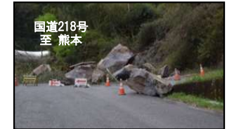
▲H28熊本地震による被災(写真①)
