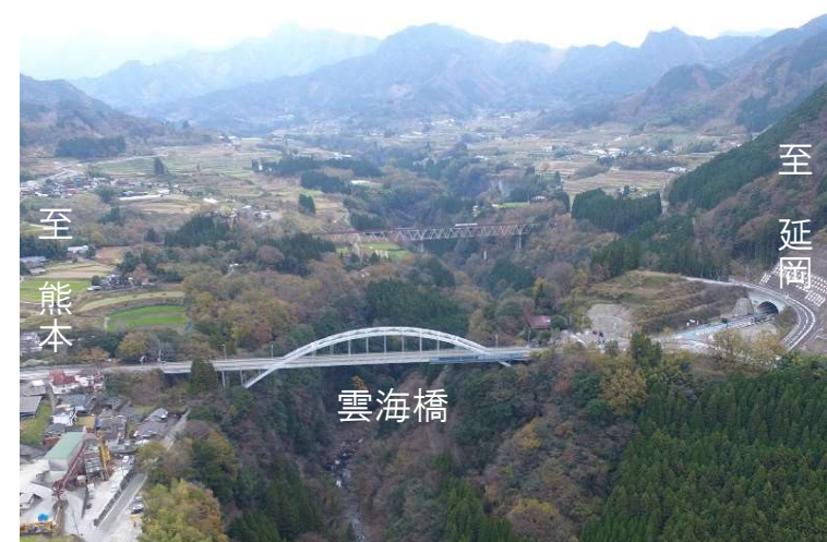
中路式ローゼ桁橋 L=199m
