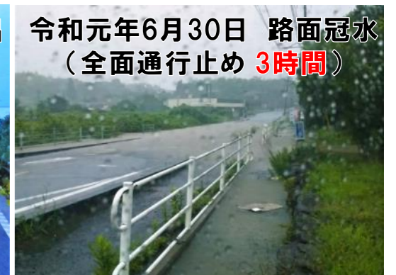
写真2 国道266号の災害状況
