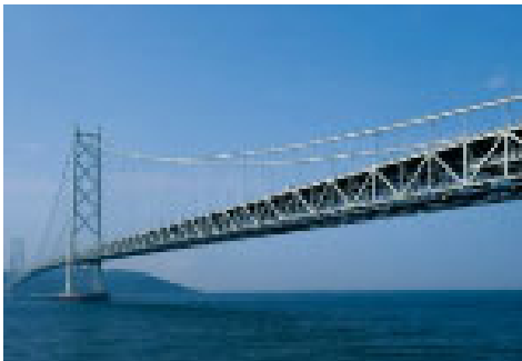
明石海峡大橋
