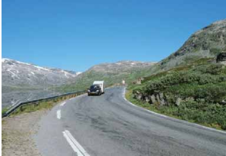
ナショナルツーリストルートの道路
