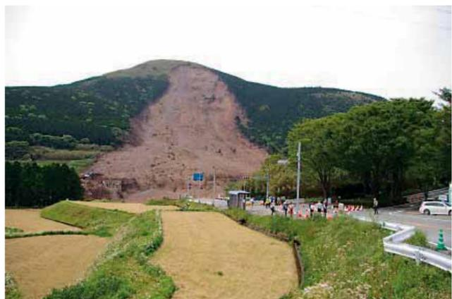
南阿蘇村阿蘇大橋を落橋させた土砂崩落（南阿蘇村立野）
