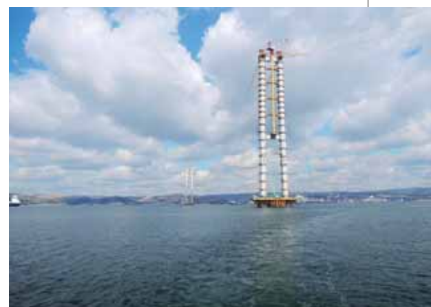
イズミット湾横断道路橋(建設中、2015年3月)
