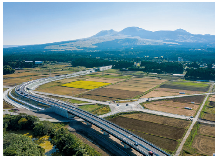
北側復旧ルート
