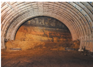
滝室坂トンネル切り刃
