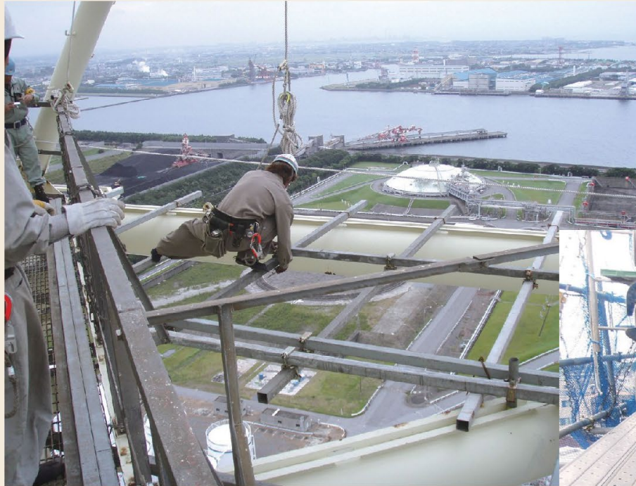
在来工法と完成した足場状態
