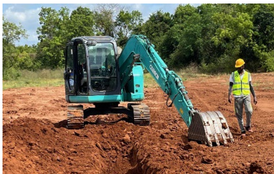
(油圧ショベルの実技講習の様子)
