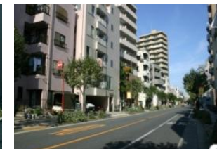
沿道建築物の不燃化
