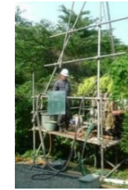
安全性把握調査 (ボーリング調査)
