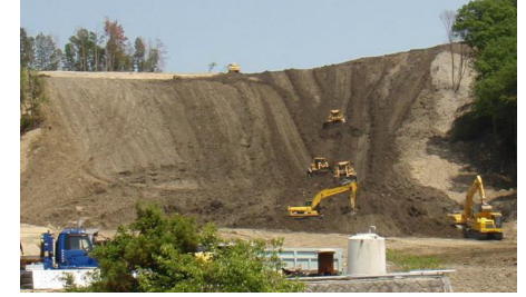
盛土撤去工事のイメージ
