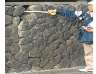
擁壁の危険度調査
