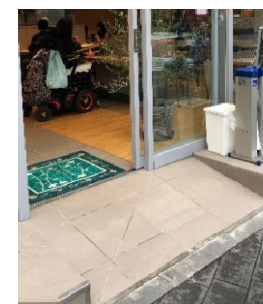
スロープの設置
