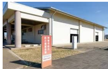
&lt;防災備蓄倉庫&gt;
