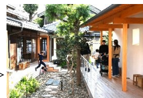
既存建築物のリノベーション (大阪府守口市)
