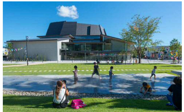
ホールの北側には広場(さくらごろごろパーク)が整備され、子ども達の日常的な遊び場となっている。
