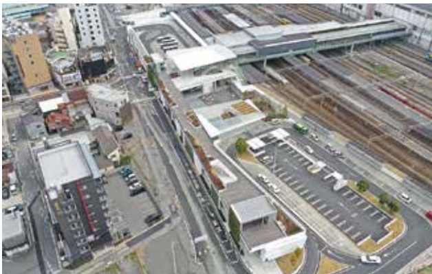
西側上空より北口駅前広場全景を望む。
