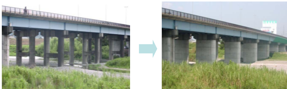
徳島県国道192号上鮎喰橋 ※
