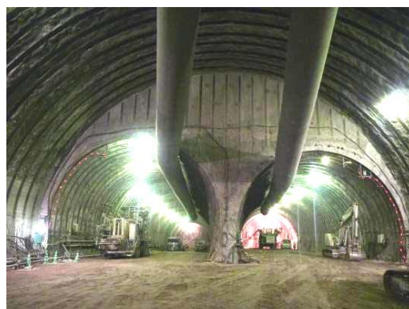
写真-2 双設トンネル発進部
