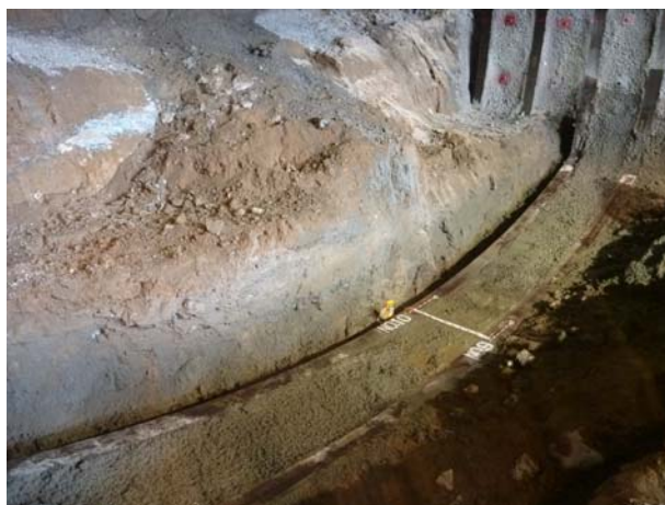
写真-6 インバート一次閉合（閉合後）
