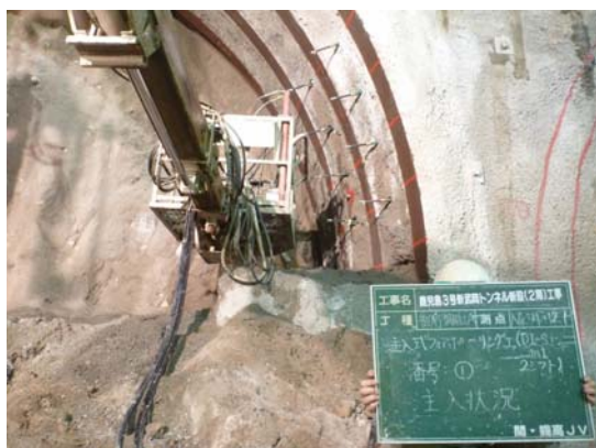
写真-3 注入による中間地山改良
