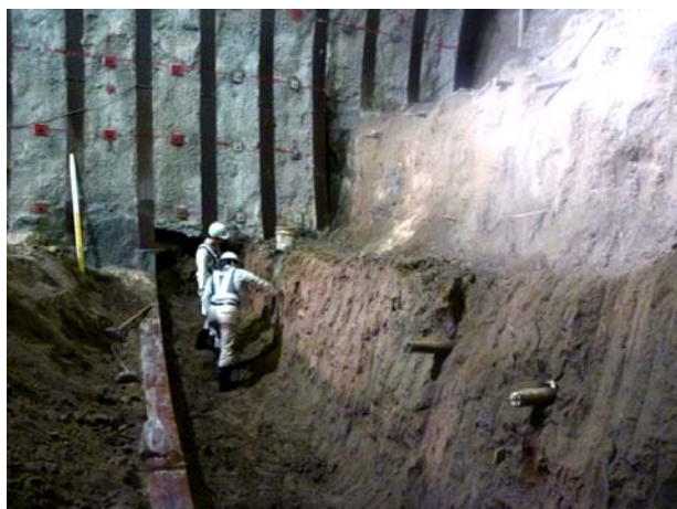
写真-5 インバート一次閉合（閉合前）
