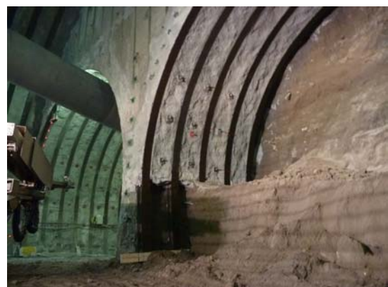
写真-4 後進トンネルの掘削
