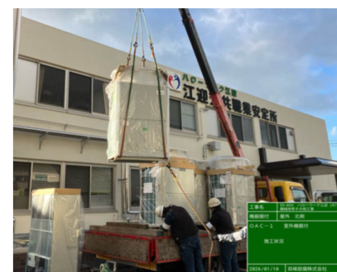
室外機搬入状況
