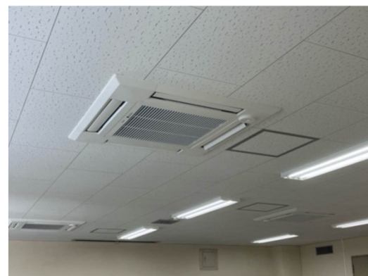
室内機設置状況
