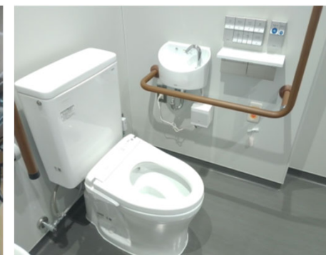
洋式トイレ設置状況
