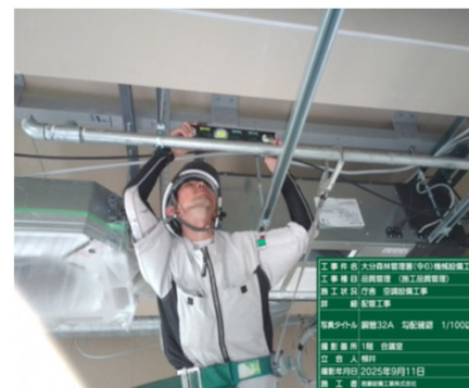
天井内隠ぺい配管の自主検査
