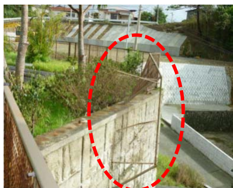
駐輪場の屋根 【台風時の強風で、 敷地外への飛散 のおそれ】
