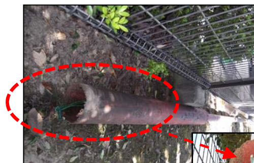
外灯ポールの根本の腐食 【台風時の強風で転倒外灯 倒による危害のおそれ】
