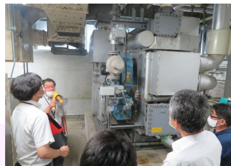
長崎地区（対面）では実際に建物で点検のポイントを解説。会議後に相談コーナーも開設します。
