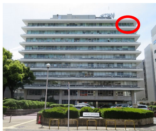
営繕部調整課は福岡第2合同庁舎10階です
