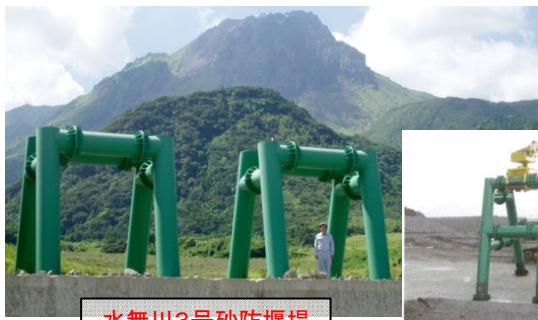
水無川3号砂防堰堤
