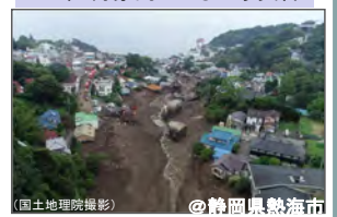
R3年7月豪雨による土砂災害
