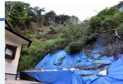
豪雨の度に 土砂崩れが多発
