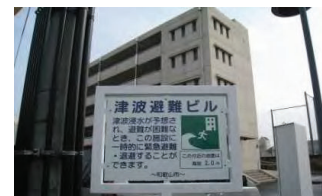
津波避難ビルに指定されている国家公務員宿舍 (和歌山市・近畿財務局)
